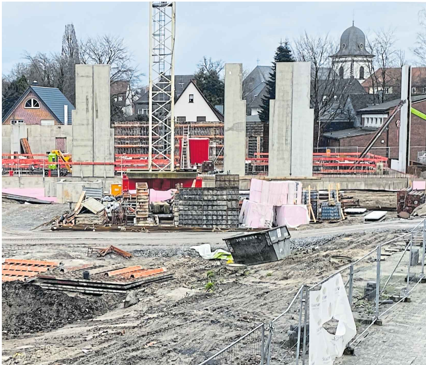
In Verl hat die „Zukunft der Schule“ längst begonnen. Der Neubau der Gesamtschule zur „Schule der Zukunft“ ist in vollem Gang. Auch hier werden moderne Raumkonzepte umgesetzt. Im Hintergrund ist der Turm der Pfarrkirche St. Anna zu sehen. Foto: Markus Voss
